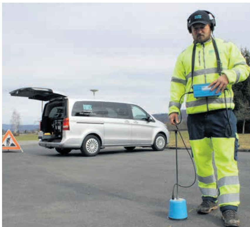
Sven Ramseier von der Riwaterc AG bei der Arbeit: Mittels Bodenmikrofon ortet er eine undichte Stelle im Wasserleitungsnetz. Foto Pascal Vogel
